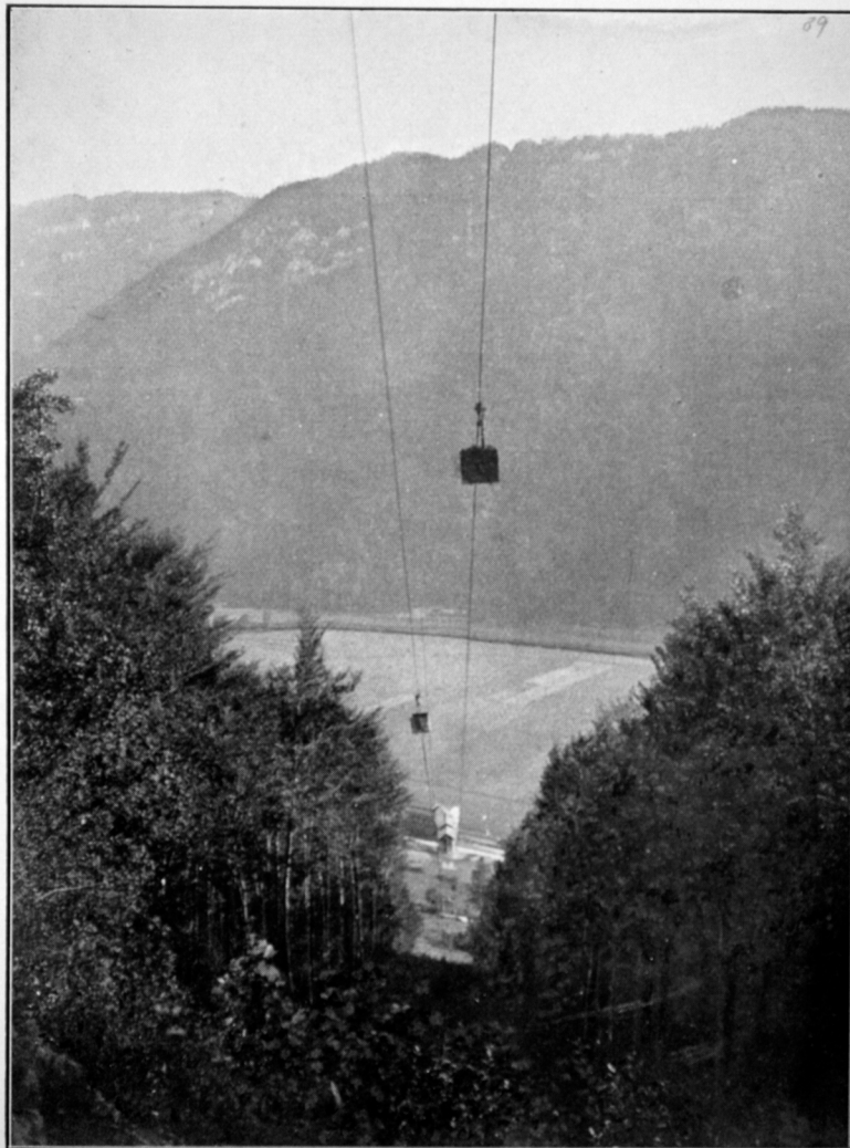
Seilschwebebahn grosse Spannweite (Seite Noiraigue)
